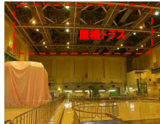
原子炉建屋 屋根トラス
