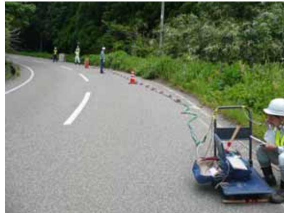
地下探査 (表面波探査)
