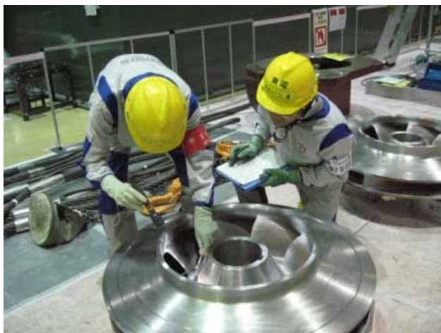
1号機 低圧復水ポンプの点検
