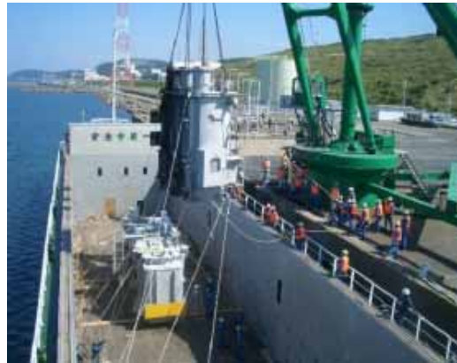
所内変圧器の搬出作業
