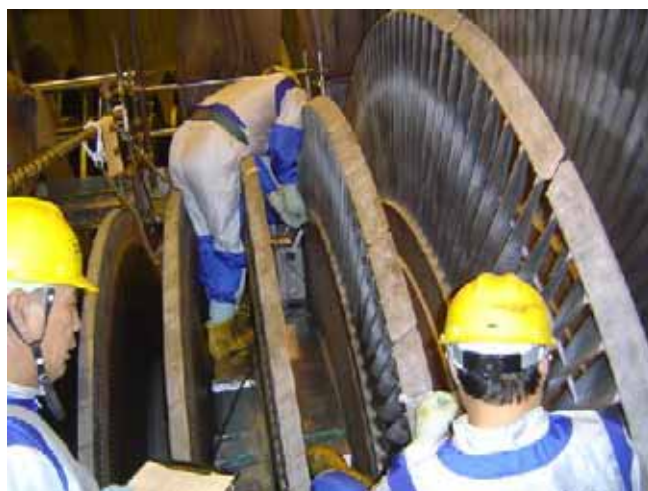
7号機 タービン翼の点検
