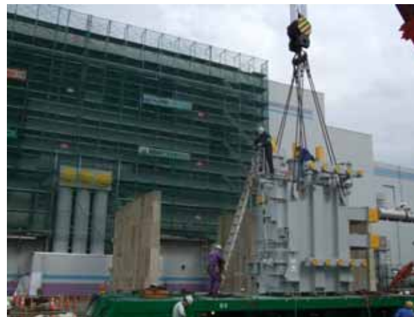
所内変圧器の搬入作業
