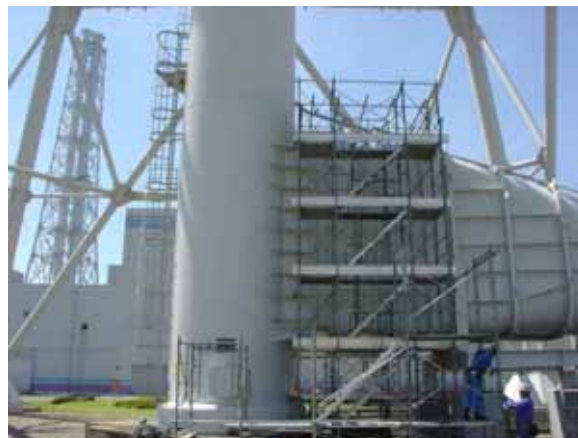
3号機 排気筒の点検
