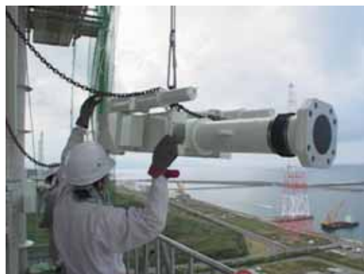
制震装置の取り付け
