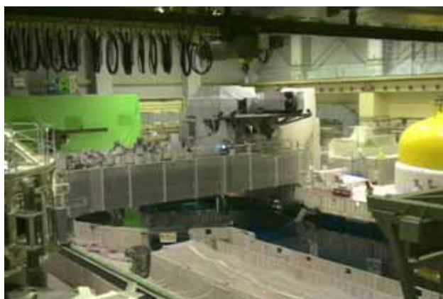
1号機 原子炉内の点検 (2007年8月21日)
