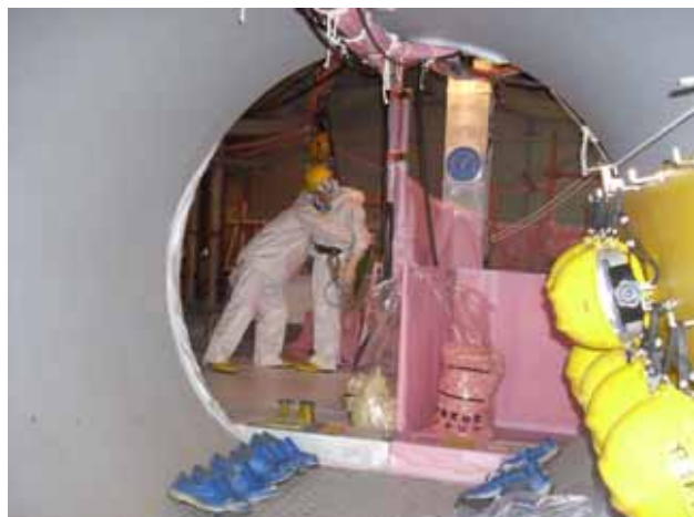
7号機 圧力抑制室の点検
