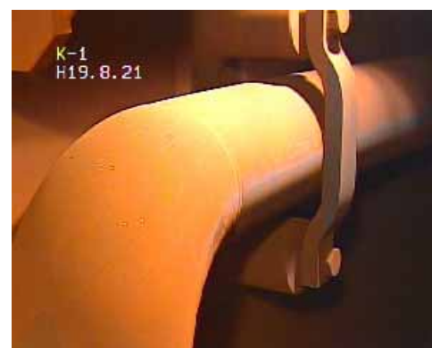
1号機 炉心スプレイ配管
