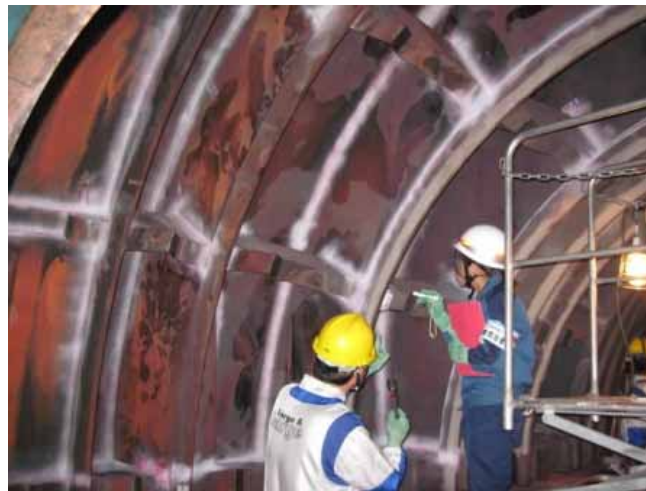
3号機 タービン本体の点検
