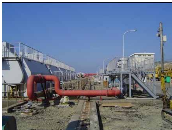
スクリーン設備点検・修理
