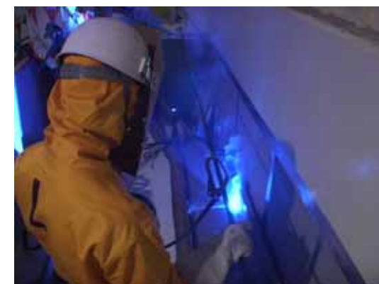
溶接工事(補強材の取り付け)
