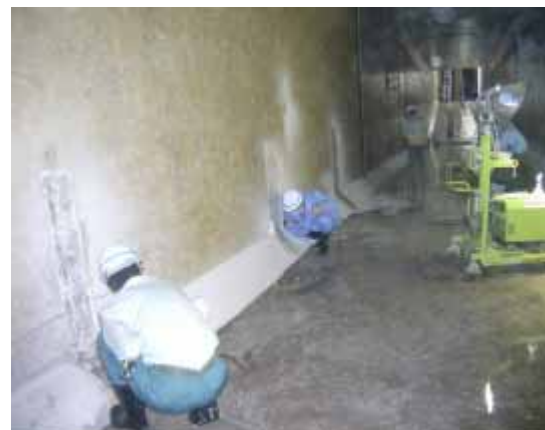
7号機 非常用取水路の点検
