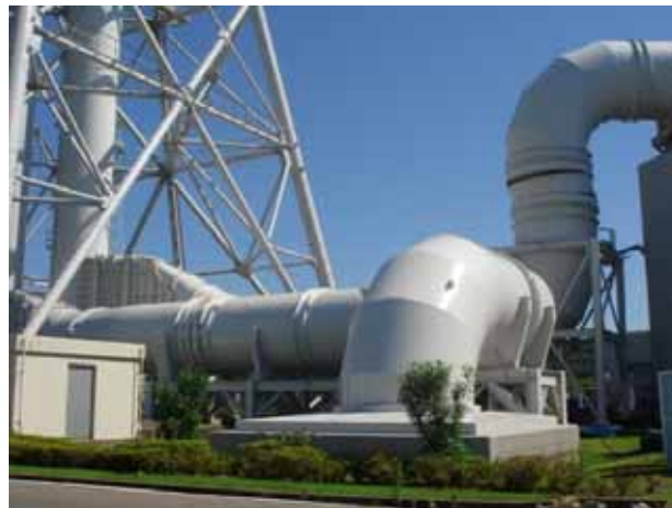
1号機 排気筒 (2007年7月24日撮影)
