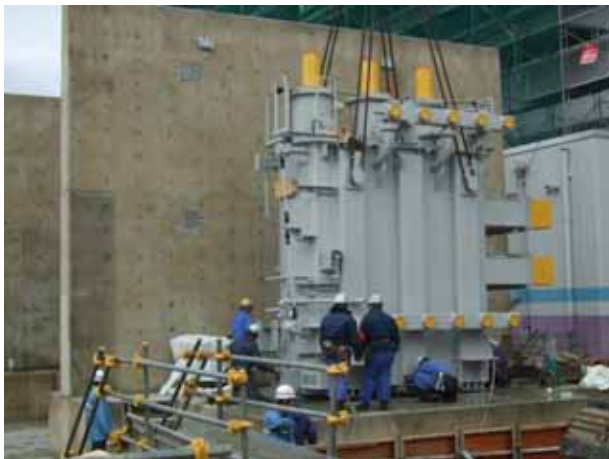
所内変圧器の据え付け作業
