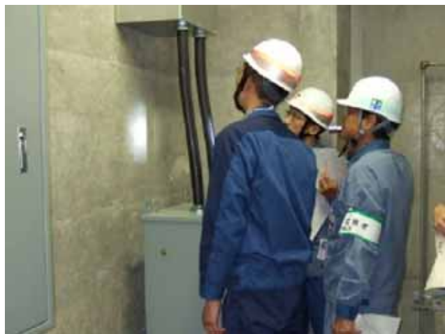
(7号機) 原子炉建屋耐震壁の点検
