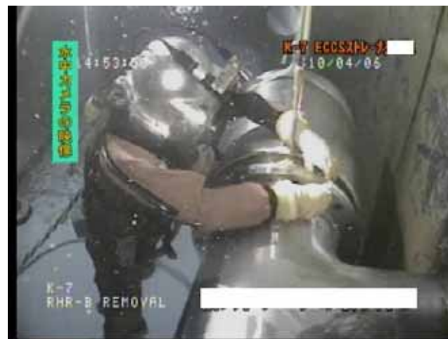
7号機 圧力抑制室の点検 (潜水作業)
