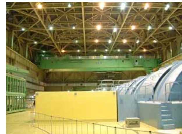
1号機 タービン建屋内 (2007年8月10日撮影)
