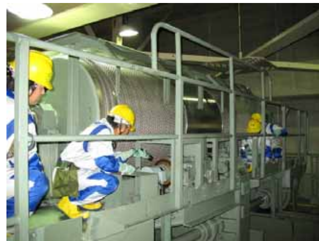
2号機 天井クレーンの点検
