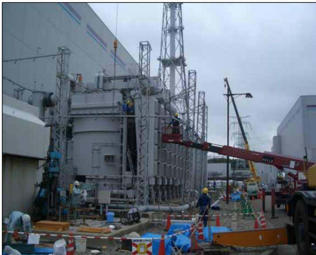
【損傷した3号機 主変圧器の解体工事】
