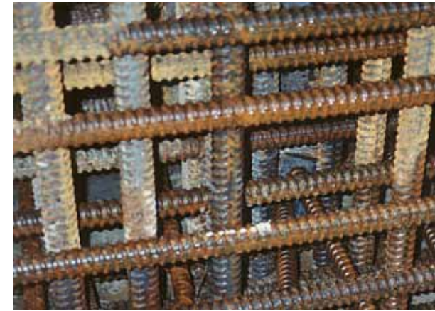
7号機原子炉建屋の配筋例
