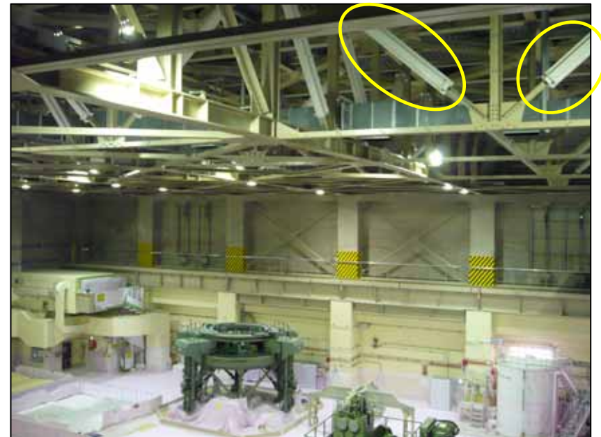
【 強化工事後の屋根トラス 】
