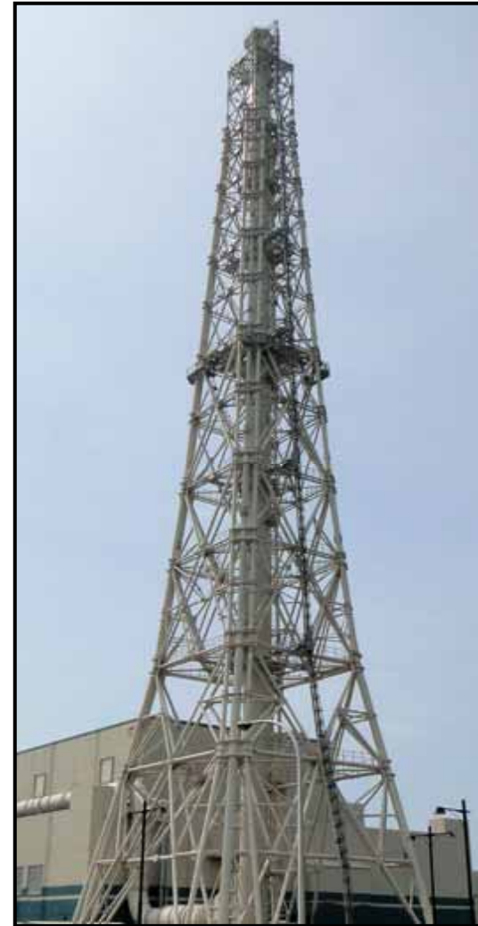
【強化工事後の5号機排気筒】
