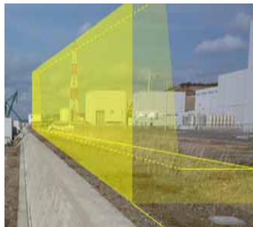
1～4号機側(擁壁タイプ)
