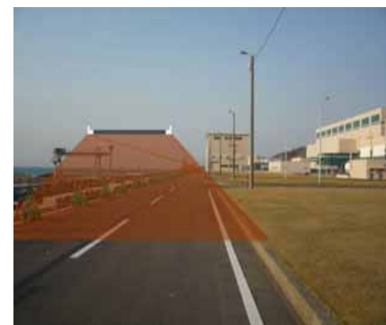
5～7号機側(盛土タイプ)
