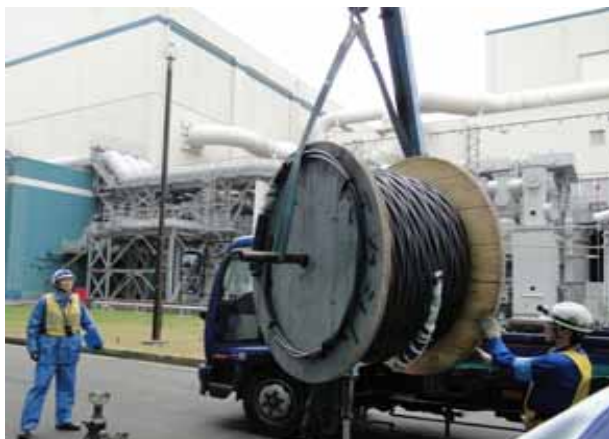
仮設ケーブルの準備
