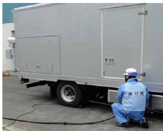
電源車へのケーブル接続
