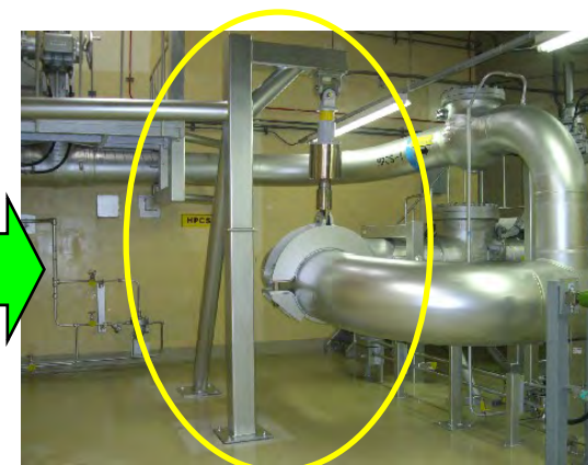
配管サポートの追設（5号機の例）
