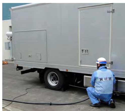
電源車へのケーブル接続
