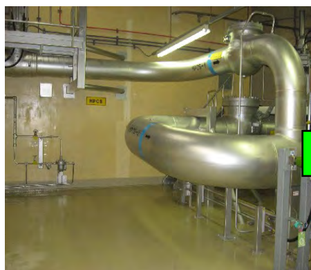
配管サポートの追設（5号機の例）
