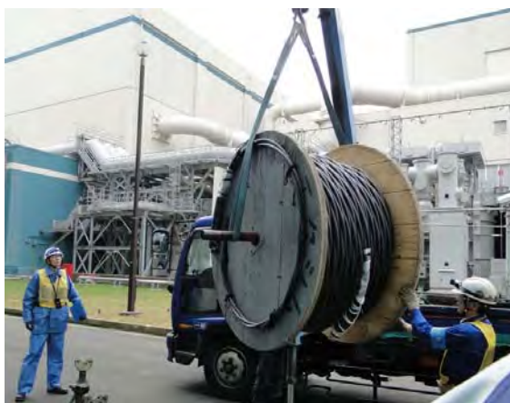
仮設ケーブルの準備
