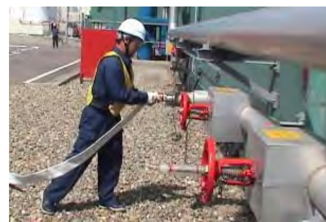
消防ホースの注水ライン接続
