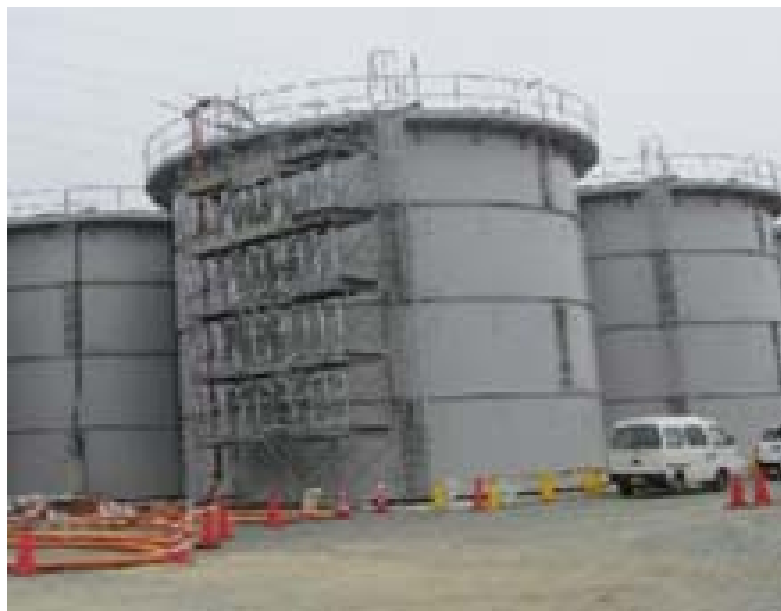
鋼製円筒型タンク (フランジ接合)
