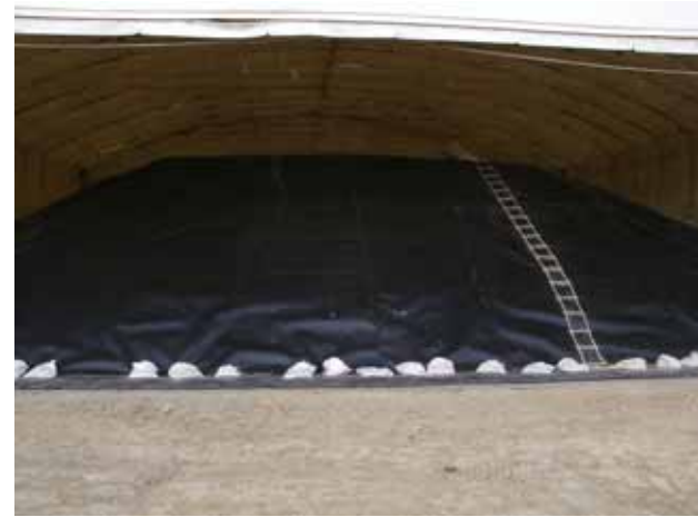
1 槽目内部の状態 (H24/12/13)
