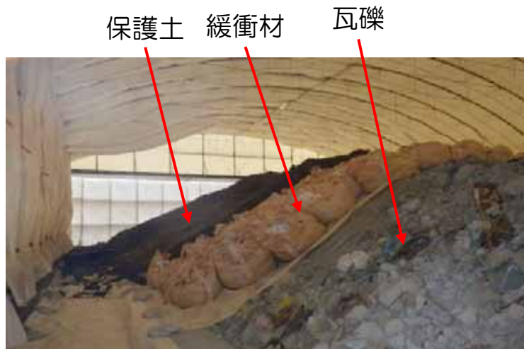
1 槽目内部の状態 (H24/11/1)
