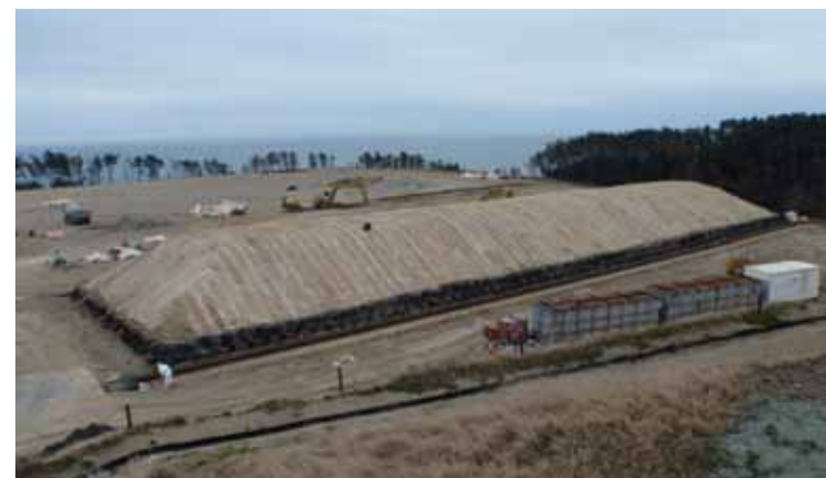
1 槽目の外観 (H25/3/27)
