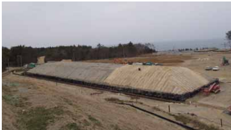
2 槽目の外観 (H25/3/25)
