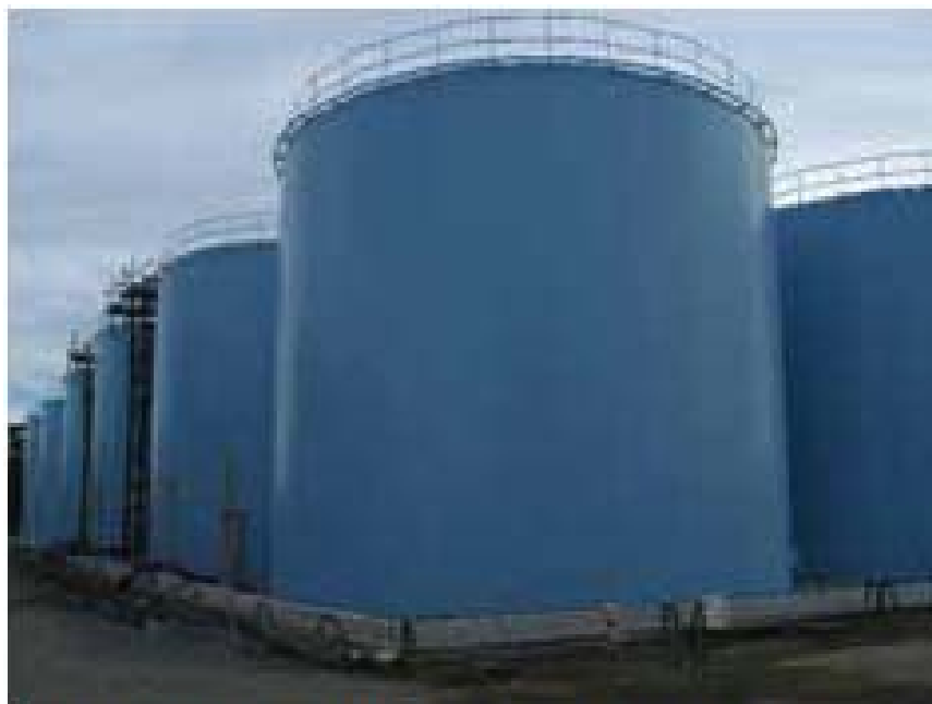
鋼製円筒型タンク（溶接）
