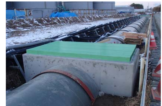
写真② 暗渠化施工完了(FRP管)
