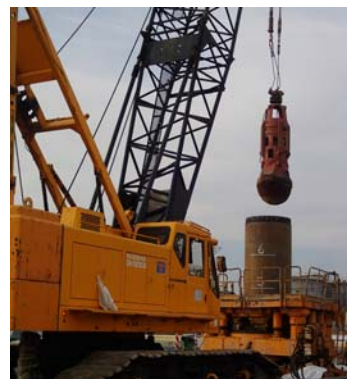
土壌改良（掘削）
