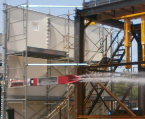
壁パネル外し前 に壁パネルに孔をあけ、側面からガレキに飛散防止剤を散布
