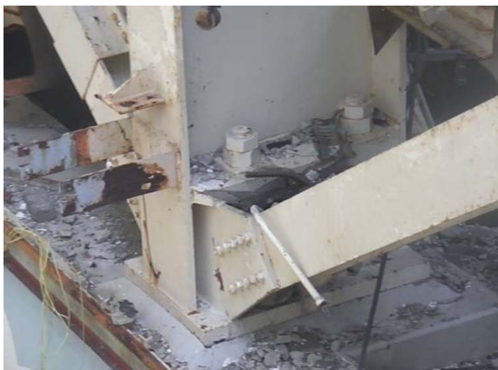
② 9a通り柱脚 健全
