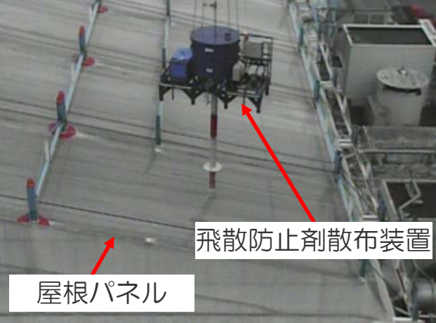
屋根パネルへの孔あけ状況
