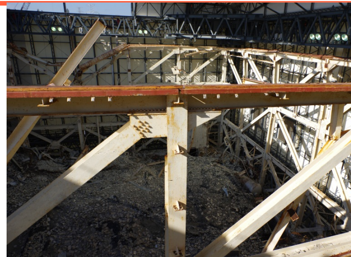
① 7a柱上部梁 健全
