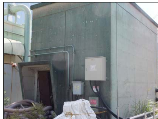
⑦セメントブロアー室
