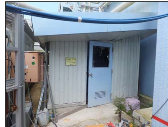
④HCU窒素ガスポンベ室
