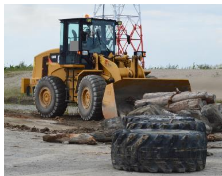
ガレキ撤去訓練
