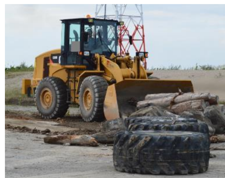
ガレキ撤去訓練
