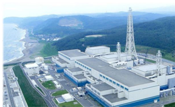
柏崎刈羽原子力発電所
