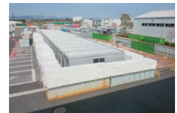
休憩施設 (免震棟前)
