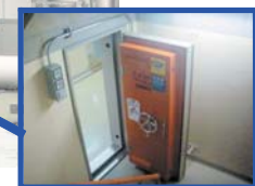
建屋内 重要機器室 扉の水密化
