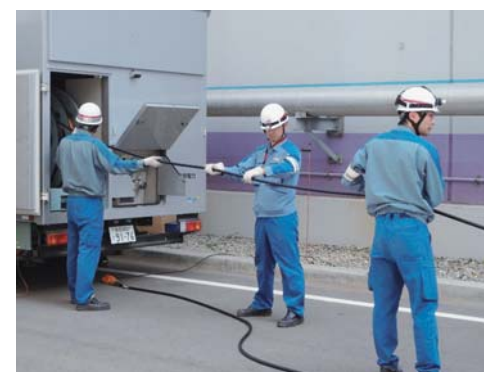
電源車からのケーブル引き出し
