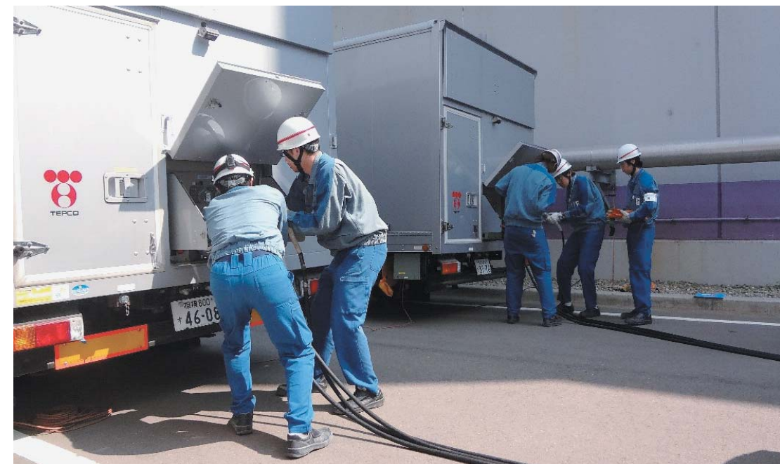
電源車へのケーブル接続
