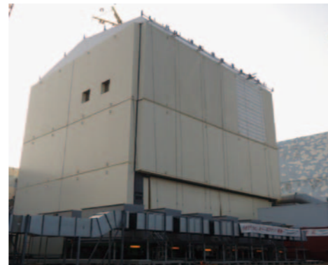
福島第一原子力発電所 1号機 原子炉建屋カバ（放射性物質の放出を抑制するために設置）
