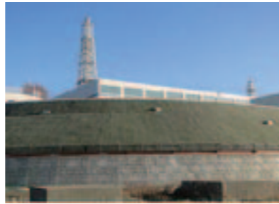
5~7号機側防潮堤
