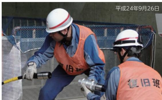
電源車からプラントへの電源ケーブル接続訓練
