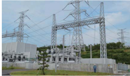
外部からの電気の入口となる開閉所
