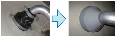
壁の貫通部の止水対策の例
