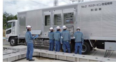
空冷式ガスタービン発電機車
