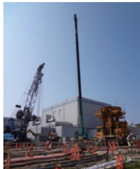
1～4号機側の立坑による調査
