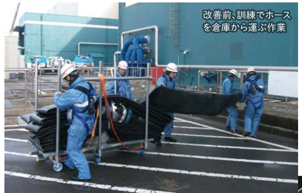
倉庫から運んだホースを代替熱交換器に接続する作業
