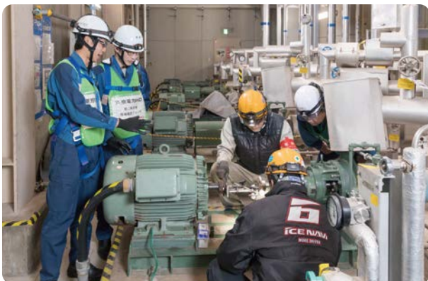
水処理建屋での現場立ち会い
