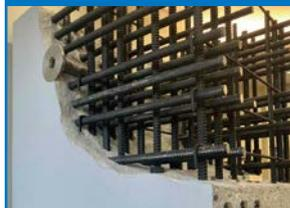
原子炉建屋は、一般の建物より太い鉄筋や厚い壁を使い、大きな力を受けても変形しにくい構造で建設
