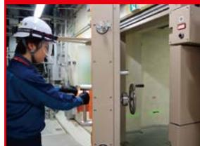
事故時に炉心を冷やす装置や非常用電源等、重要な設備がある部屋には、浸水から守るため水密扉を設置
