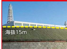
海拔12mの敷地に高さ約3mの盛土をし、海拔15mの防潮堤を設置(5~7号機側)
