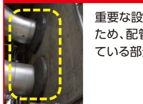
重要な設備がある部屋への浸水を防ぐため、配管やケーブル等が壁を貫通している部分を止水処理
