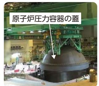
原子炉压力容器の蓋を閉じている様子
