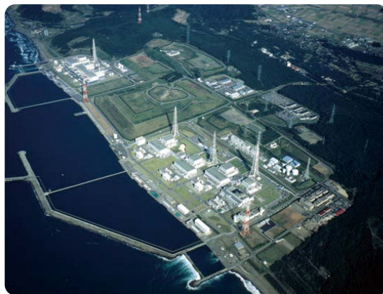
柏崎刈羽原子力発電所 建設後
