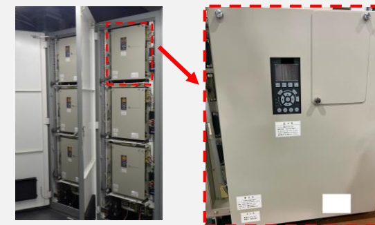
電動機制御盤
