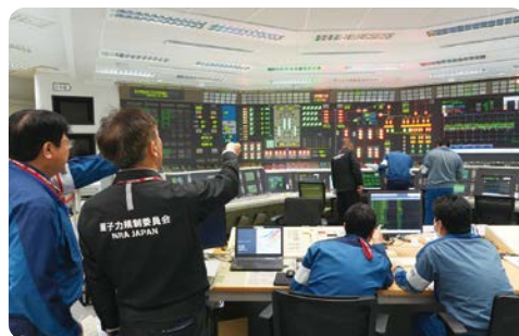
総合負荷性能検査の様子
