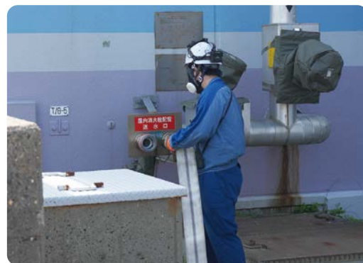
1号機の建屋へホースを接続する様子
