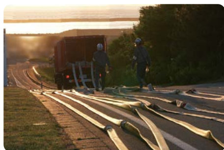
貯水池からホースを敷設する様子
