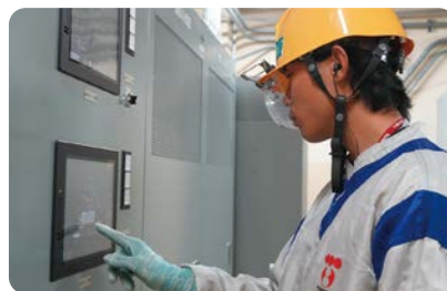
データの確認をしている様子
