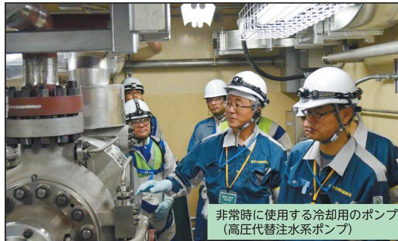
非常時に使用する冷却用のポンプ（高圧代替注水系ポンプ）
