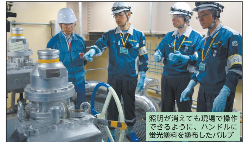
照明が消えても現場で操作できるように、ハンドルに蛍光塗料を塗布したバルブ
