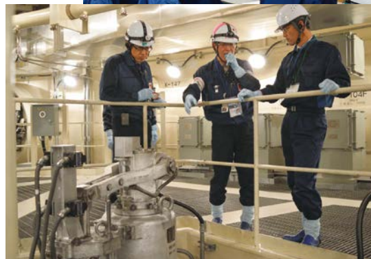
主蒸気逃がし安全弁の 役割について説明
