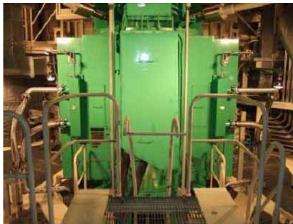
原子炉冷却材 再循環系ポンプ
