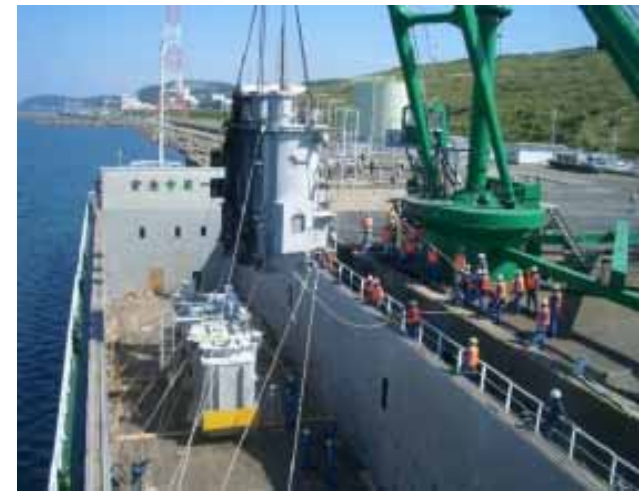
3号機 所内変圧器の搬出
