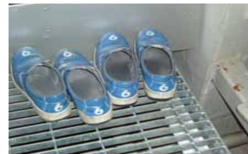
作業靴履替え所の近くに開口部
