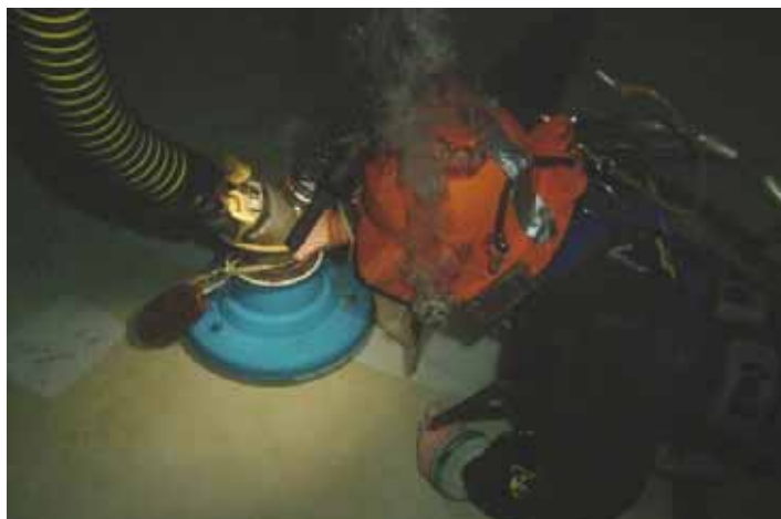
ダイバーによる潜水作業 (S.G.Pinney&Associates.inc.提供)
