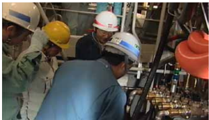
現場パトロールの様子
