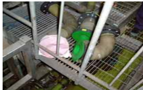
取り外した配管についても 開口部養生
