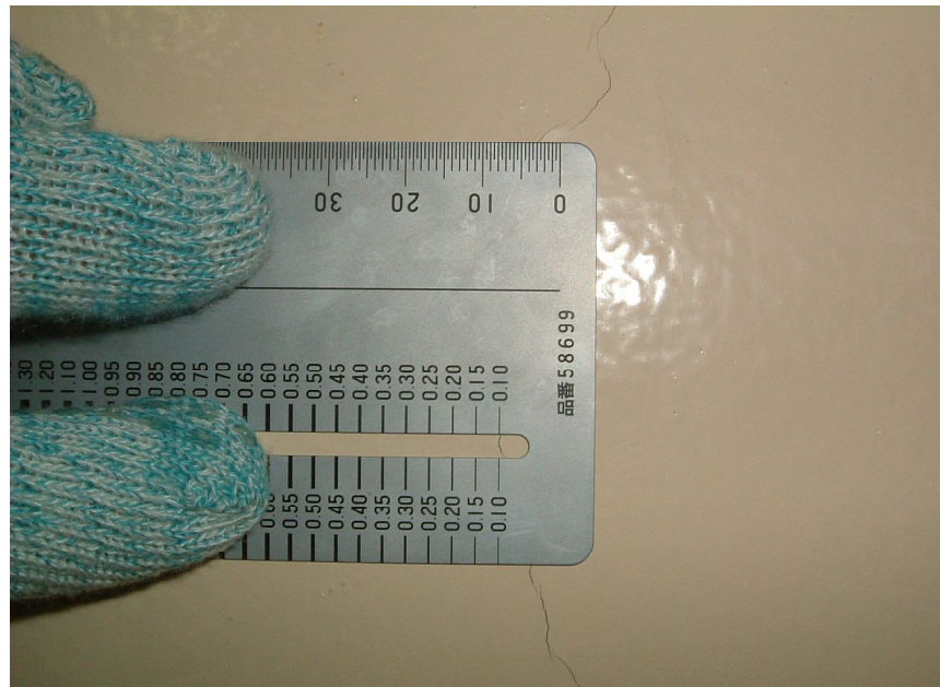
(ひび割れ幅の測定状況)
