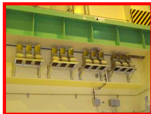
静的触媒式水素再結合装置 (PAR)
