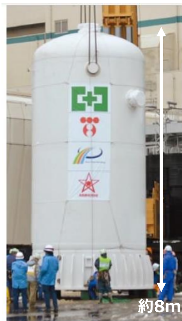
放射性物質を除去する フィルタベント装置
