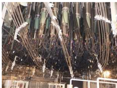
制御棒駆動機構
