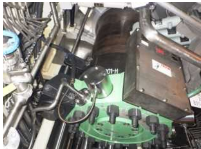
原子炉内蔵型再循環ポンプ
