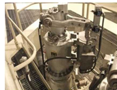
主蒸気隔離弁
