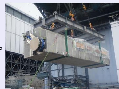
2号機原子炉建屋内に搬入
