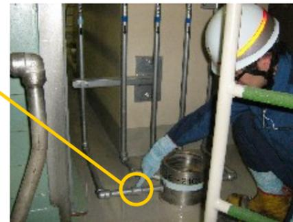
柏崎刈羽原子力発電所 1号機原子炉隔離時冷却系蒸気管差圧検出配管の接続調査の概要
