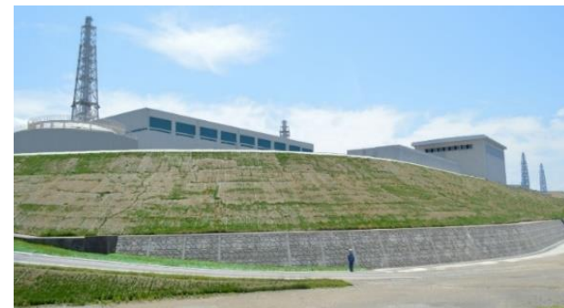
【防潮堤（5～7号機側）】
