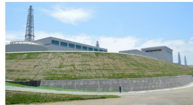
【防潮堤（5～7号機側）】
