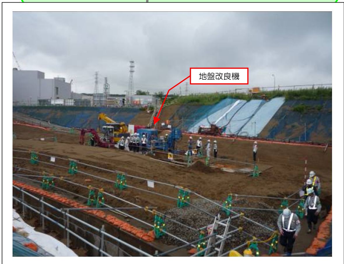
火災発生場所
