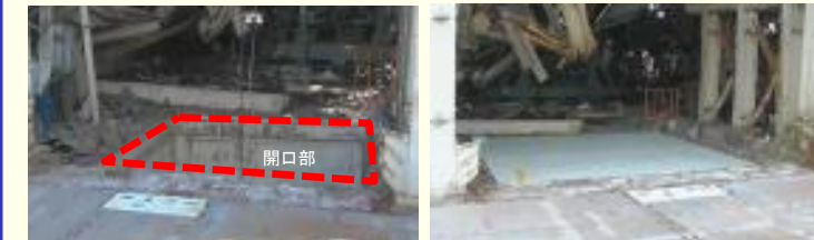
開口部養生カバー設置前 開口部養生カバー設置後
