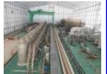
(高性能多核種除去設備)
