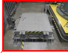
取水槽閉止板
