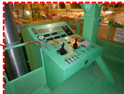
①燃料取替機操作盤
