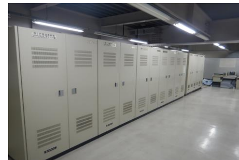
②燃料取替機制御盤 ※オペレーティングフロアに隣接する制御室に設置
