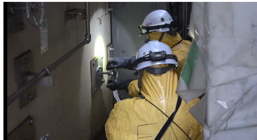
格納容器ベント操作
