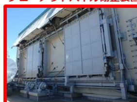
ブローアウトパネル閉止装置
