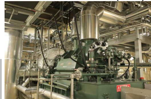
6号機原子炉隔離時冷却系(RCIC)
