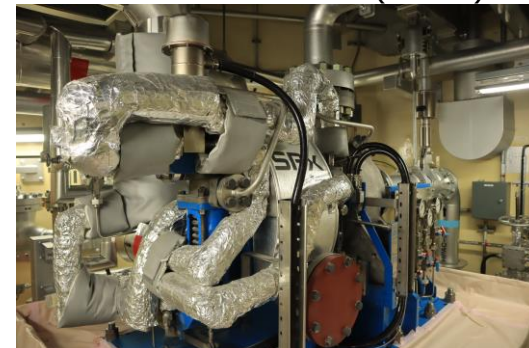
6号機高圧代替注水系(HPAC)
